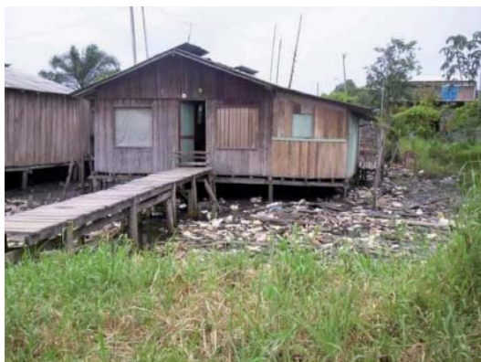
Asentamiento Brisas. Zona con disposición inadecuada de basuras-
